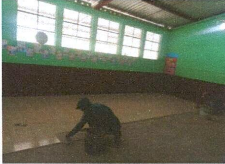
Foto7: Sustitución de piso de torta por piso cerámico aula de segundo
