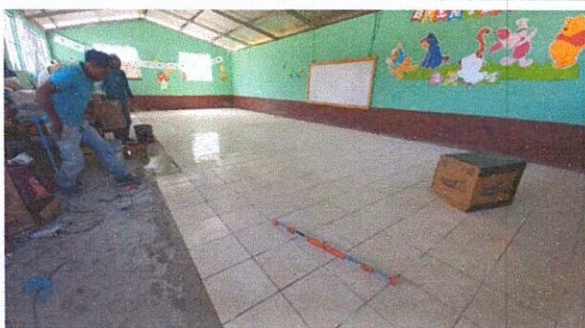
Foto 5: Sustitución de piso de torta por piso cerámico aula de Sexto
