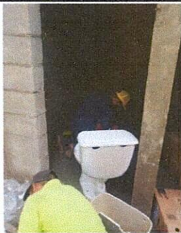
Foto 11: Sustitución de letrina por baño de cerámico.
