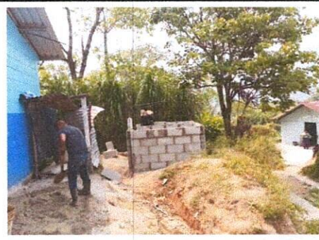
Foto 12: Sustitución de paredes de baño de lámina por block.
