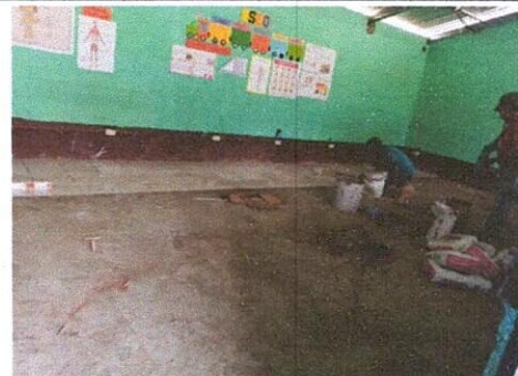
Foto 6: Sustitución de piso de torta por piso cerámico aula de tercero.
