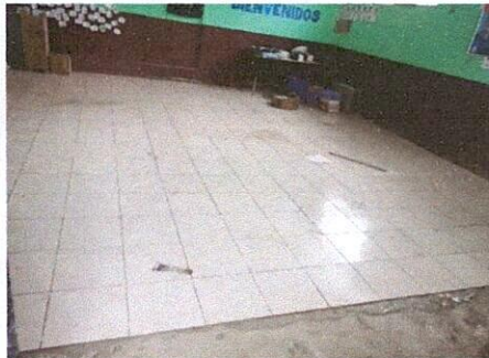
Foto 9: Sustitución de piso de torta por piso cerámico aula de primero
