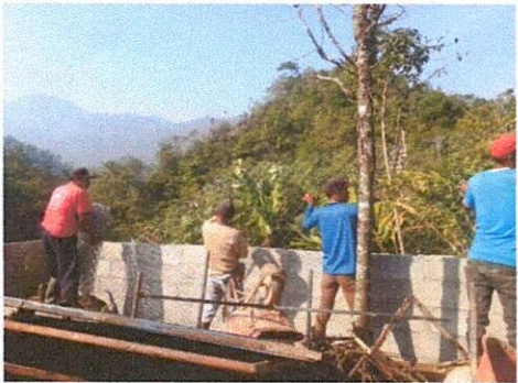
Foto 3: Sustitución de un metro malla por muro perimetral de la parte de atrás del centro educativo.
