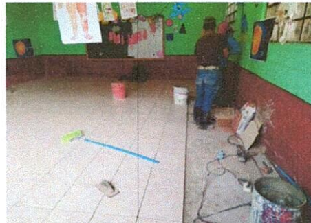
Foto 10: Sustitución de piso de torta por piso cerámico aula de preprimaria.
