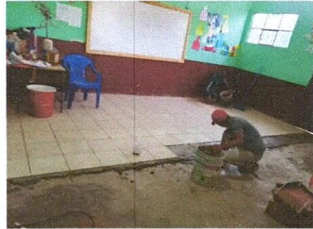
Foto 8: Sustitución de piso de torta por piso cerámico aula de quinto.
